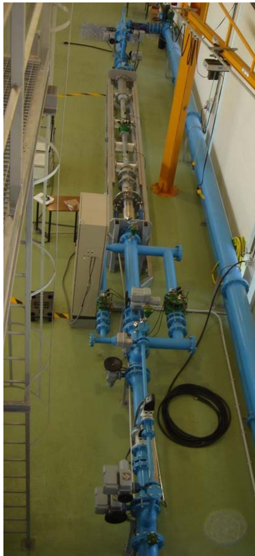
Figura 4 - Banco de pérdidas de carga y comprobación de los dispositivos de regulación
